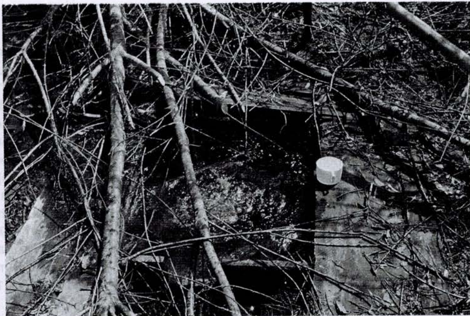
FIG. 11. Marco para la captación de aguas minerales en Manantial Yelcho, Región X; se observa abundante deposición de hierro coloidal.
